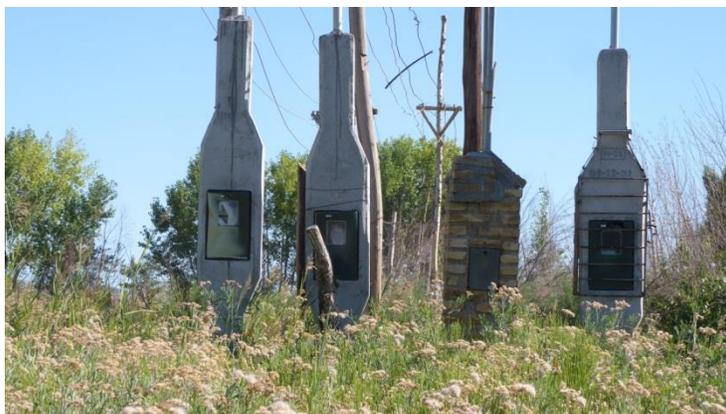
*Imagen22. Pilares de luz colocados y cableado por las propias familias de ladrilleros.*
