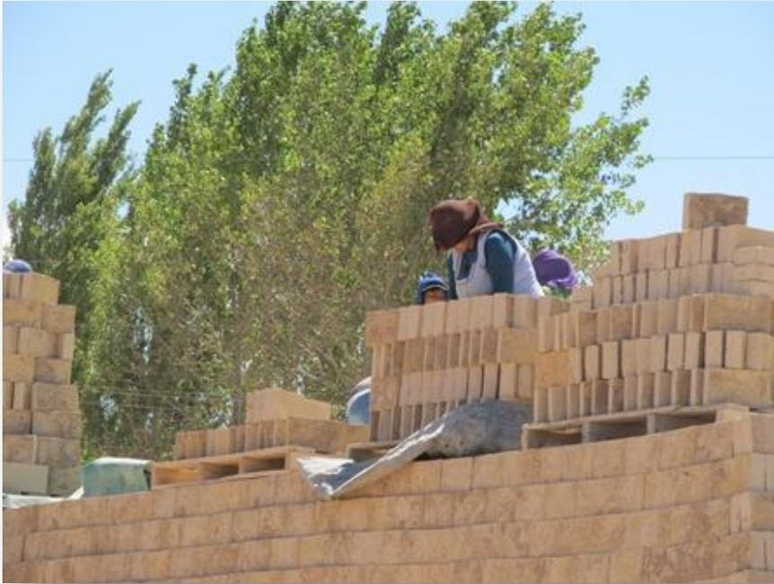
Imagen 13. Asentadoras construyendo una hornalla. Se observan los adobes sobre pallets dispuestos en la parte superior de la **hornalla** que va creciendo a medida que agregan más unidades.
