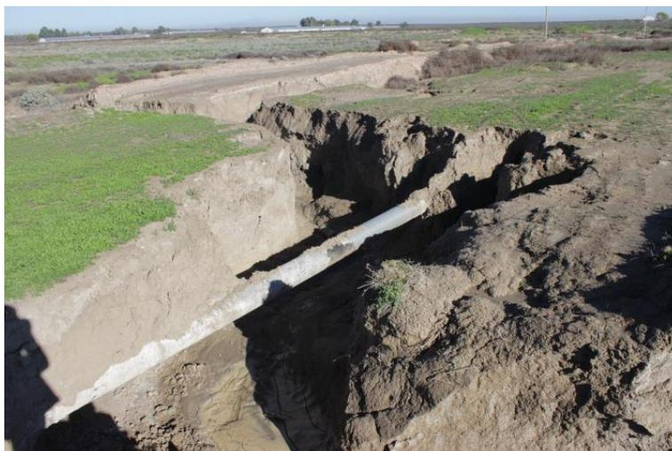
*Imagen 10. Cantera de la Asociación Árbol en el Automotoclub Allen. Exposición de un gasoducto por socavamiento natural, aunque provocado por la extensión de la explotación hasta pocos metros de la línea del ducto..*
