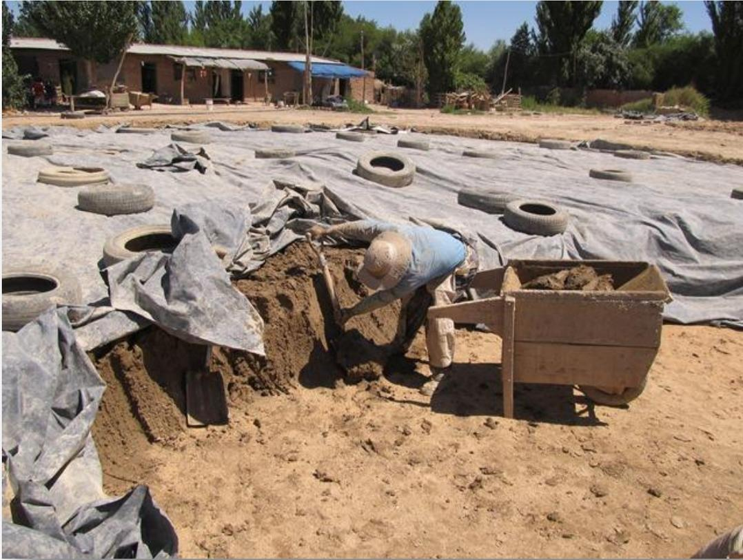
Imagen 6. **Cortador** llenando su carretilla en el pisadero. Se observa el polietileno cubriendo el resto de la mezcla.
